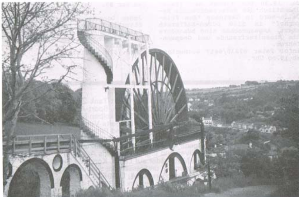
In Laxley auf der Isle of Man befindet sich das größte Wasserrad der Welt.
