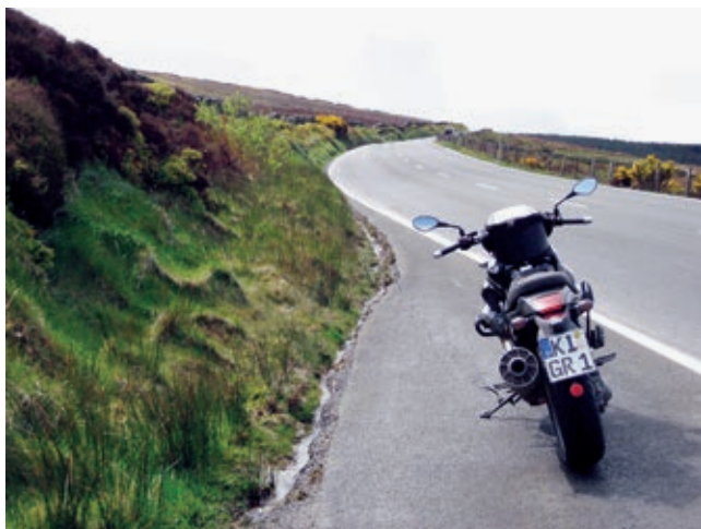
Rechtskurve mit nach außen abfallendem Asphalt.
