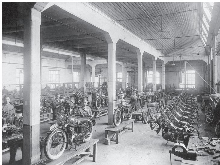
*Frera etablierte sehr früh eine industrielle Fertigung für Motorräder.*
