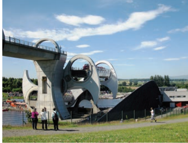
Das Falkirk Wheel ist ein außergewöhnliches Schiffshebewerk.
