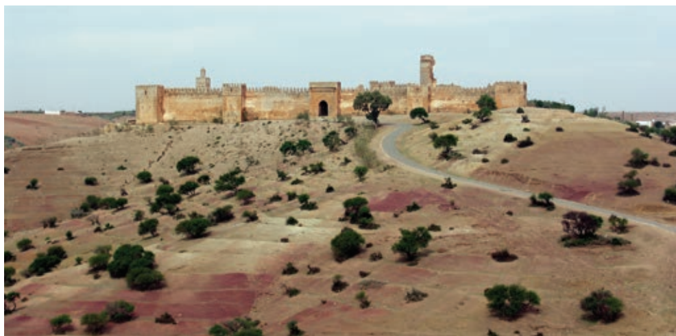
Festungsanlage in der Wüste.
