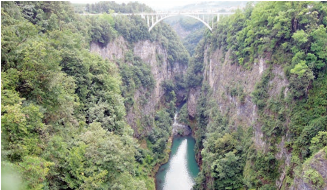
Eisenbahnbrücke Lago Di Santa Giustina.
